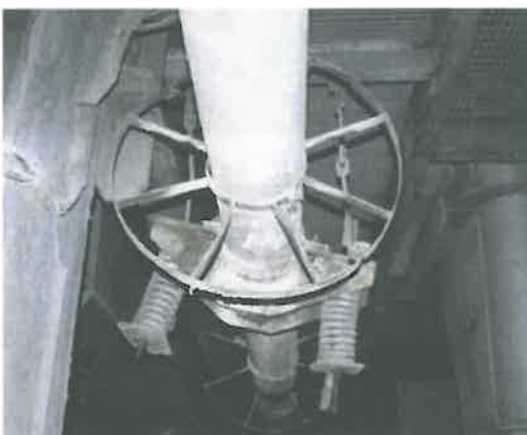
Rys. 11. Luźna i pokrzywiona obejma pozioma zamocowania dwukolumnowego
