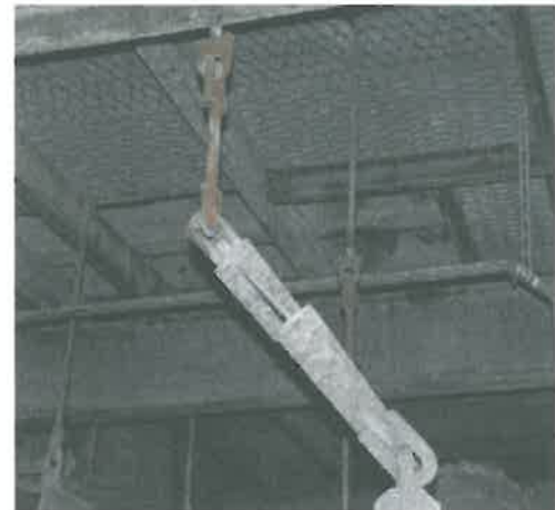
Rys. 12. Zbyt długie cięgno zamocowania
