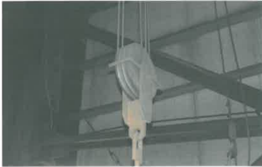
Rys. 10. Lina opasująca poza kołem roboczym zamocowania wielokrążkowego rurociągu pary do wtórnego przegrzewu bloku 200 MW
