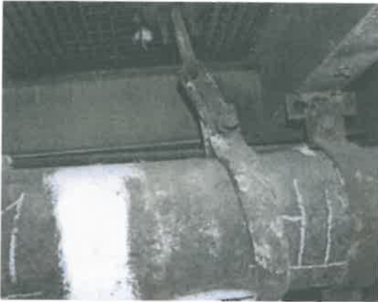
Rys. 15. Blokada montażowa pozostawiona przez ekipy remontowe – sąsiadujące z nią zamocowanie „wyłączone z pracy”
