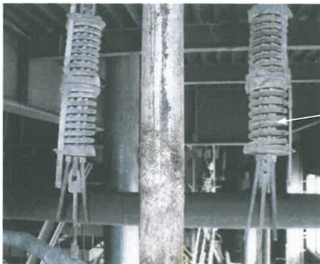
Rys. 5. Zniwelowany do zera odstęp między zwojami sprężyny, świadczący o jej złamaniu
