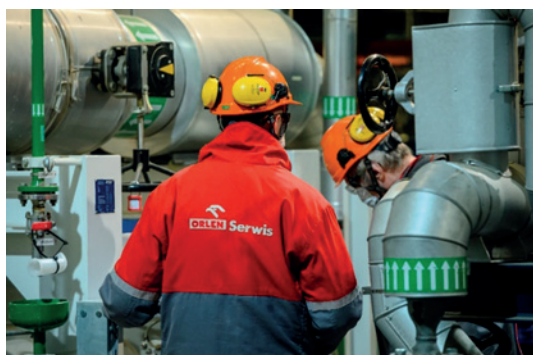
Rys. 6. Pracownicy ORLEN Serwis przy instalacji
