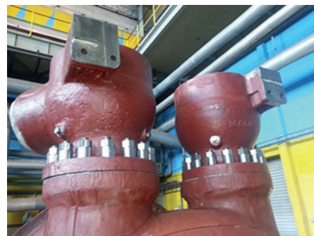
Rys. 4. Komory zaworowe SP turbiny typu 200 MW po remoncie i rewitalizacji
