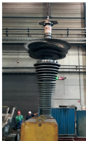
Rys. 14. Wirnik w trakcie remontu
