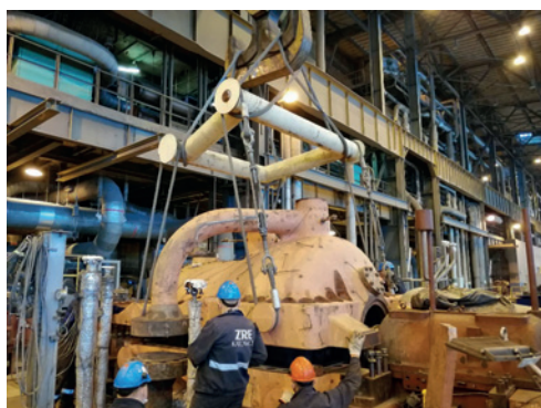
Rys. 29. Demontaż części WP
