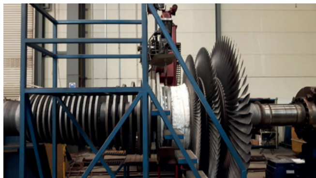
Rys. 12. Wirnik w trakcie remontu
