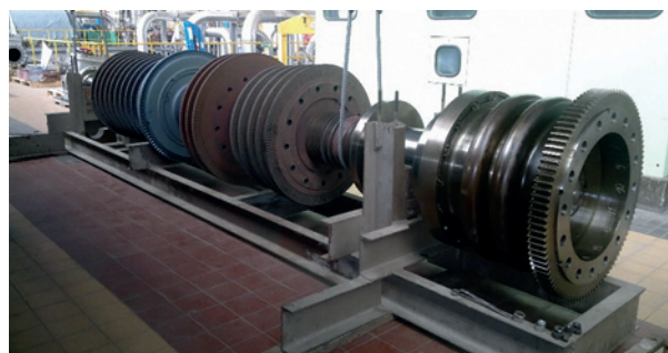
Rys. 4. Wirnik w trakcie demontażu
