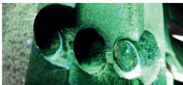
Rys. 11. Pęknięcia na mostku łopatki zamkowej, wynik badania magnetyczno-proszkowego
