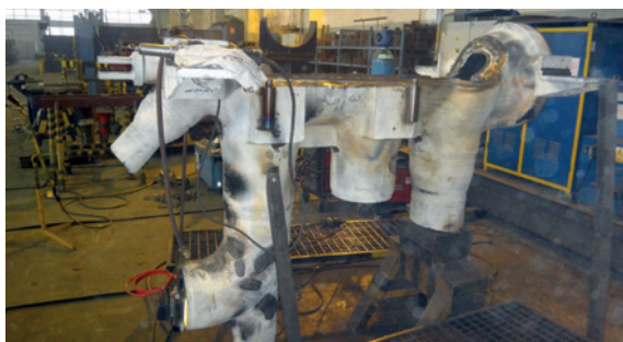
Rys. 12. Komora zaworowa w trakcie rewitalizacji
