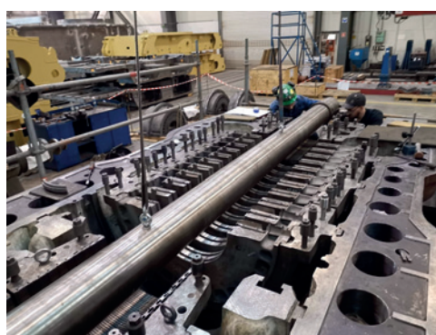
Rys. 30. Montaż części WP
