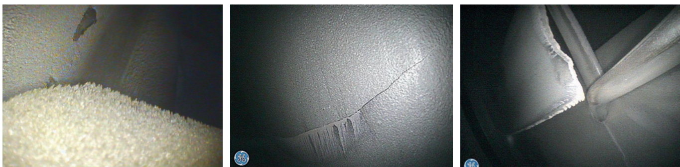
Rys. 11. Wyniki badań endoskopowych stopni wirnikowych – erozja, pęknięcie oraz urwanie łopatki
