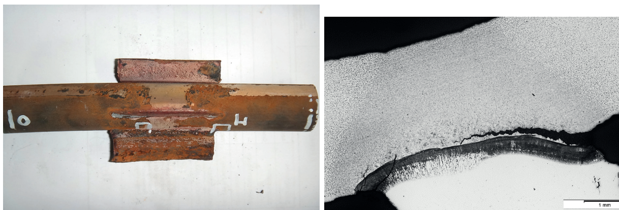
Rys. 10. Przejrzewacz pary świeżej II st. (stal 16Mo3) – pęknięcie w SWC w obszarze spoiny zamocowania
