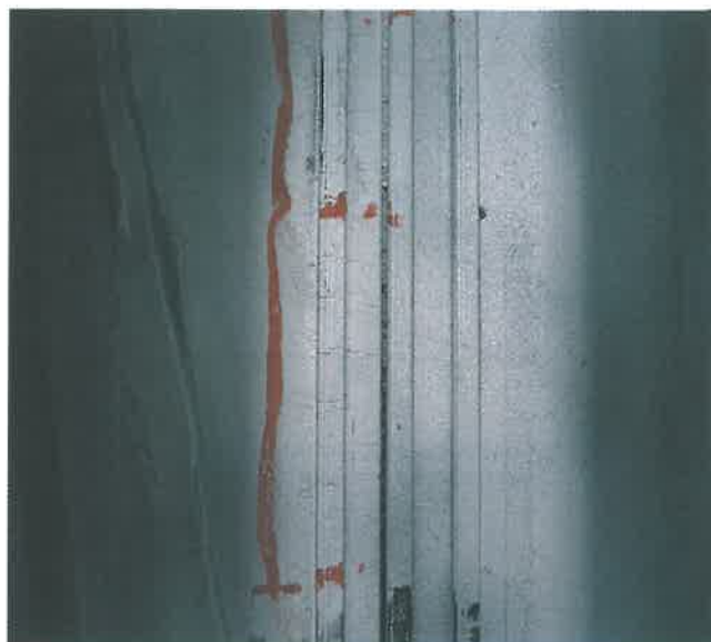
Rys. 17. Pęknięcia ujawnione na piaskie tarczy nasadzonej
