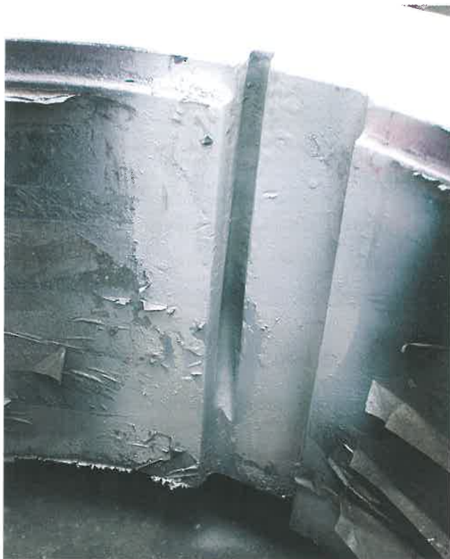
Rys. 15. Tarcza po usunięciu pęknięcia powstałego w narożu rowka wpustowego
