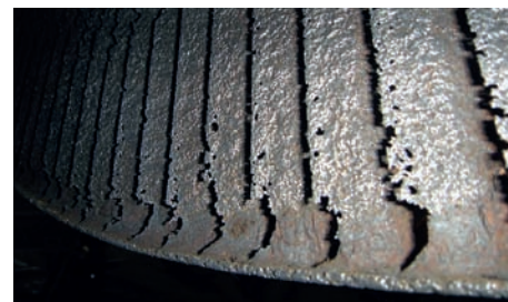
Rys. 29. Układ łopatkowy wirnika turbiny 30 MW porażony korozją postojową
