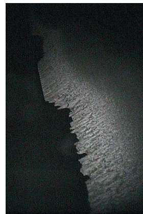
Rys. 13. Ubytki erozyjne na krawędziach wylotowych. Turbina 120 MW, wirnik NP
