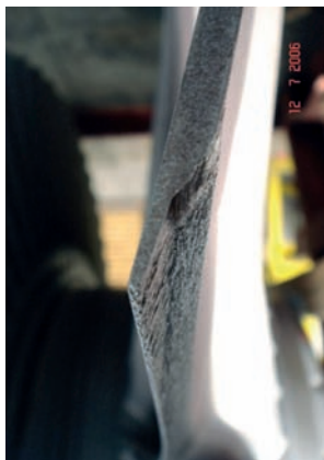
Rys. 5. Ubytki erozyjne na krawędzi wlotowej. Turbina 200 MW, wirnik NP
