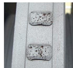
Rys. 26. Korozja postojowa. Turbina 100 MW, wirnik turbiny
