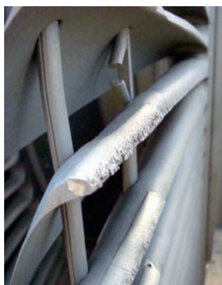
Rys. 9. Ubytki erozyjne na krawędziach wlotowych. Turbina 100 MW, wirnik NP
