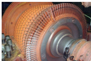
Rys. 25. Korozja postojowa. Turbina 5 MW, wirnik turbiny
