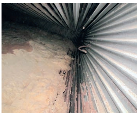
Rys. 12. Szlakowanie rur ekranowych jako rezultat spalania biomasy oraz pracy kotła z licznymi uruchomieniami i obniżonym minimum technicznym
