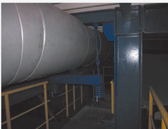
Zamocowanie Z3 dwukolumnowe, poziome zawieszenie sprężynowe
